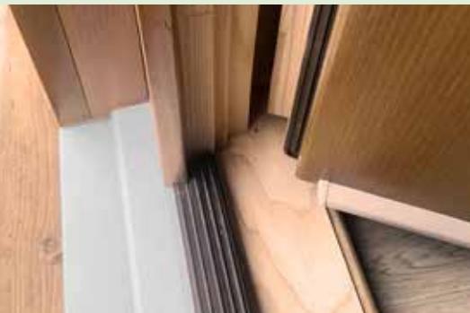
Türschwelle mit thermischer Trennung
