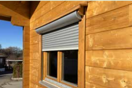
Fenster mit Rolladen
