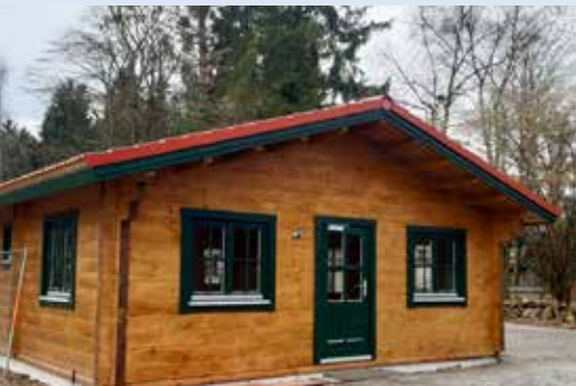
Waldkindergarten Bad Buchau 100mm Wandstärke
