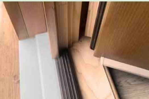
Türschwelle mit thermischer Trennung
