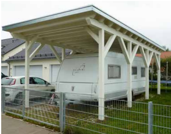
Flachdach ohne Seitenwände
